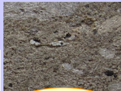
凝灰岩の内部構造。すき間が多いことがわかる。
