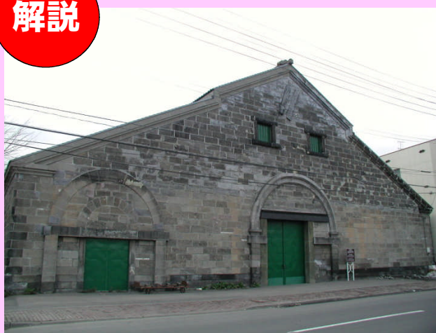
溶結凝灰岩（札幌軟石）のできた倉庫（北海道小樽市）
